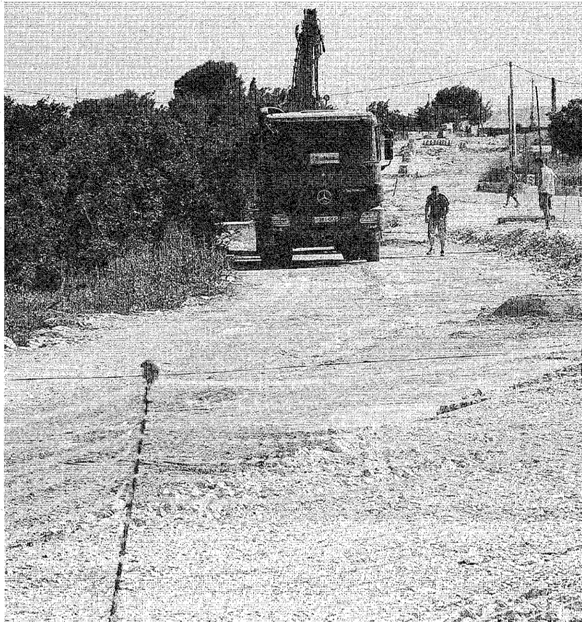
Obras de reparcelación en Lliria, donde se iba a construir el campo de golf y 2.000 viviendas. de LP
